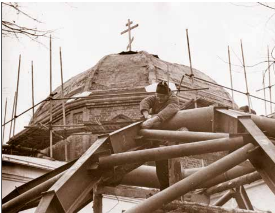
Установка каркаса купола
