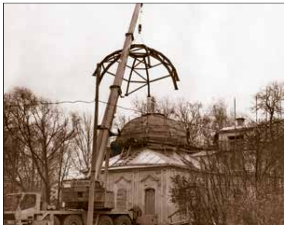
Установка каркаса купола
