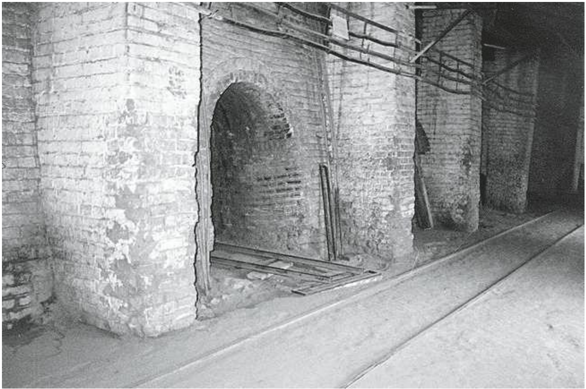
Камеры для обжига кирпича гофманской печи на верхнекотельском заводе, которые установили еще в 1889 году и сохранились до нашего времени. Фото 2000 г.
